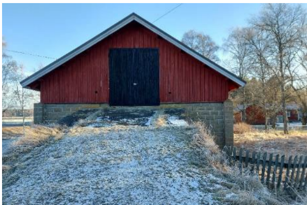
Navetan alaosa on tehty sementtitiilestä.
