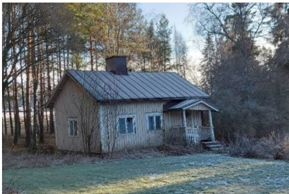
Saunarakennus sijaitsee hieman erillään pihapiiristä.
