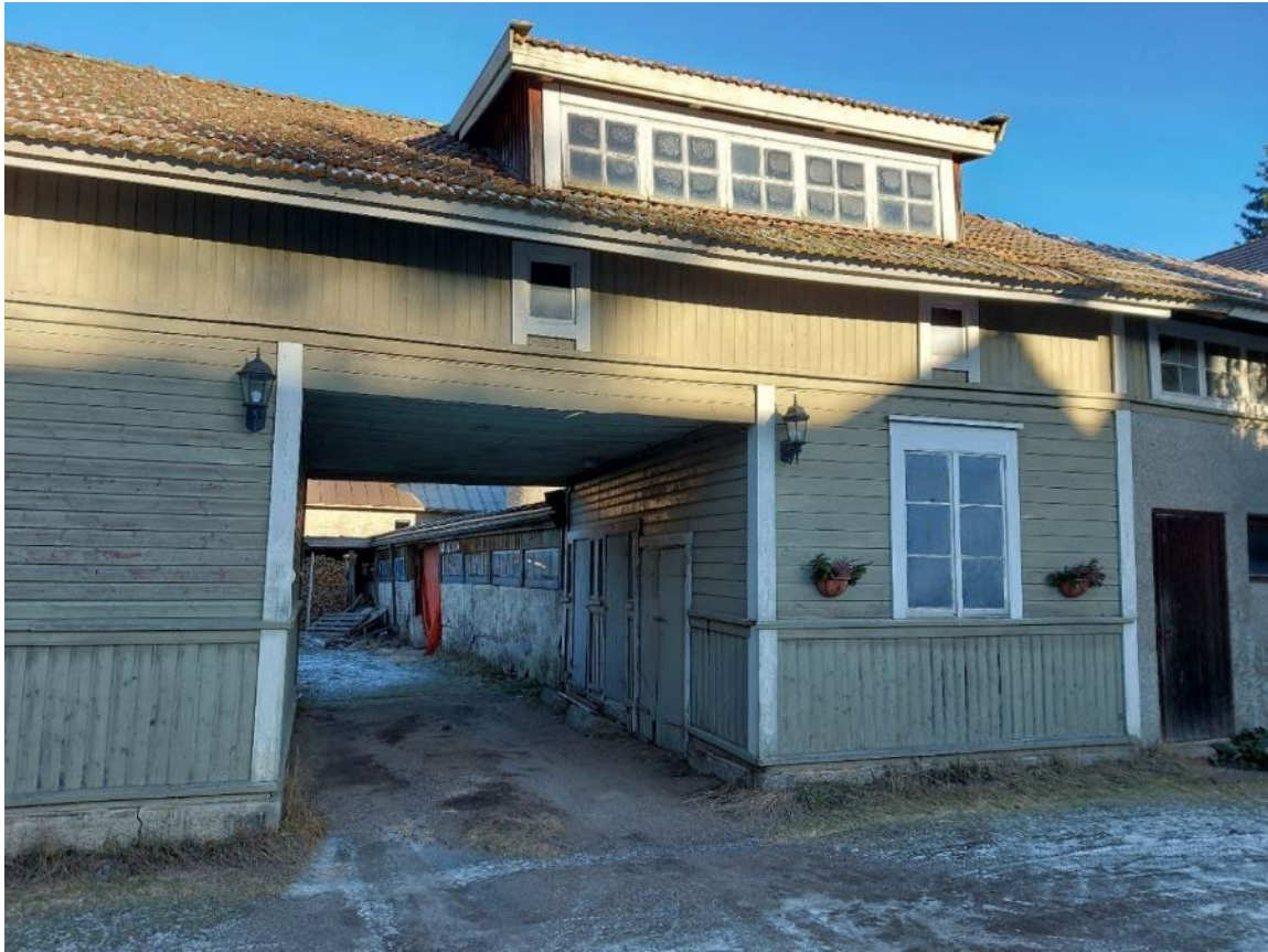
Työväen asuinrakennuksen keskellä on porttikäytävä karjapihalle.
