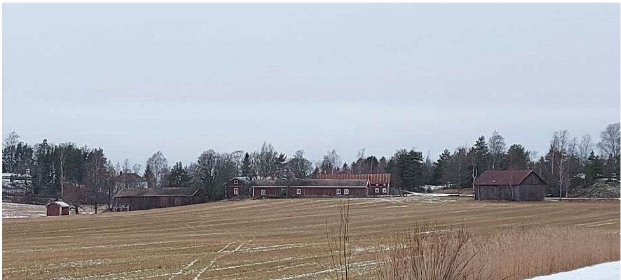
Kallentalon ja Antintalon (taaempana) rakennuksia Vahdontieltä kuvattuna.
